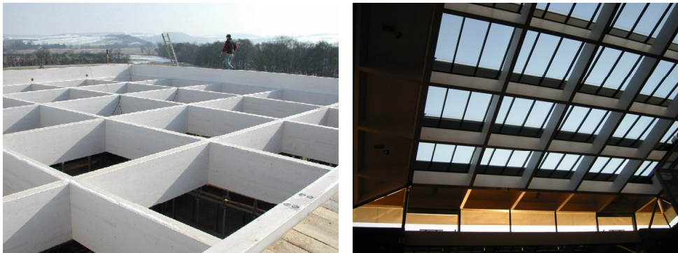
Abb. 3 links: Tragkonstruktion des Atriumdachs im Bau, rechts: Blick vom EG im Atrium auf das Sheddach.
