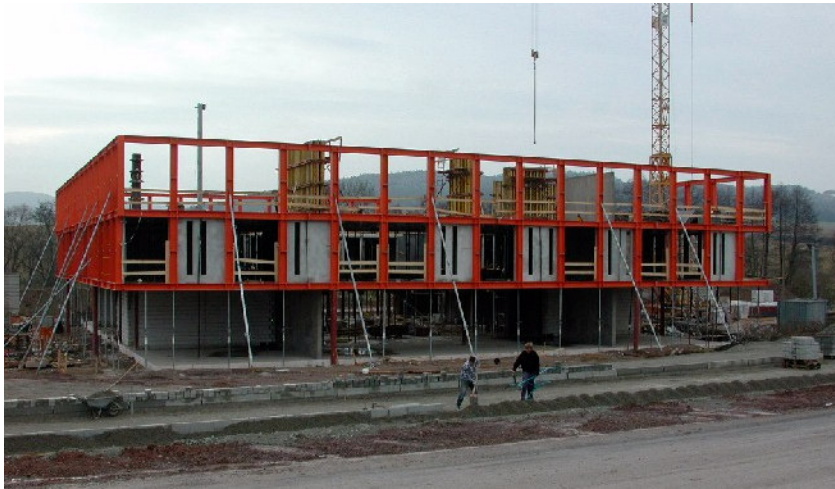
Abb. 2 Stahlskelettkonstruktion des Gebäudes. Im 1. OG sind bereits die vorgefertigten Wandelemente aus Beton zur Erhöhung der internen Masse des Gebäudes erkennbar.
